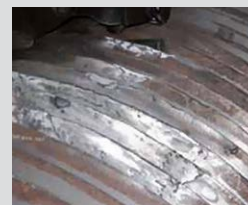
Reconstrucción de dientes de maza
