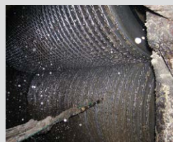
Aplicación de chapisco
